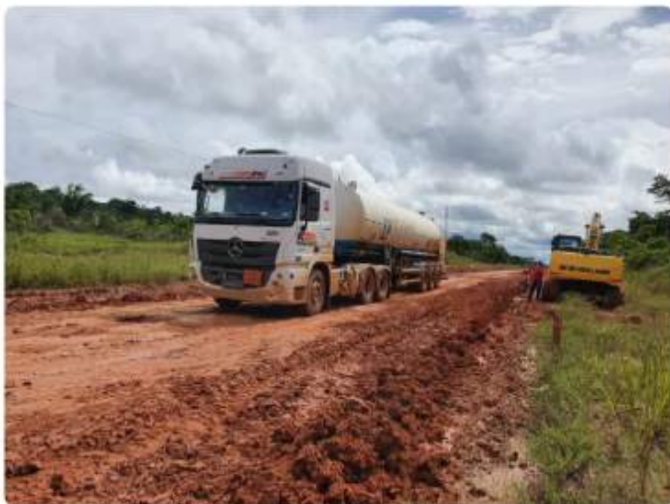
Caminhão passa por trecho sem asfalto na BR-319 — Foto: Arquivo pessoal
